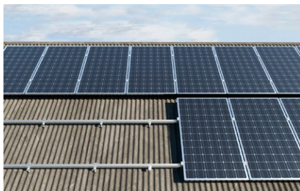
Copertura inclinata con rivestimento in lastre ondulate.
