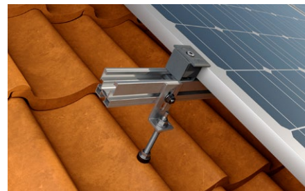
Copertura inclinata con rivestimento in tegole.
