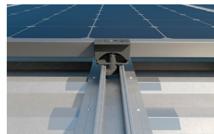
Copertura con rivestimento in lamiera grecata.
