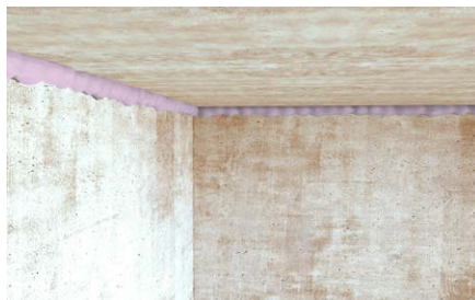
Giunti di chiusura in opere strutturali.
