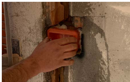
Pre-fissaggio di scatole elettriche.
